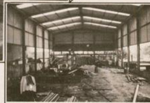
Ginásio: fundações, estruturas e... cobertura concluídas
